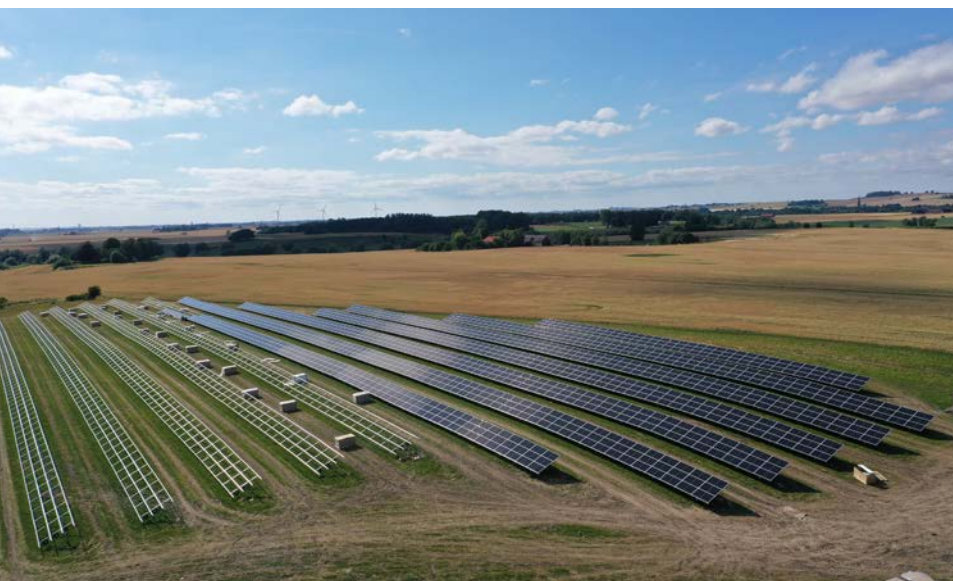
FIGUR 7 Exempel på solpaneler på markställningar. Den vänstra bilden visar pågående montering med markställningar utan solpaneler till vänster och markställningar med solpaneler till höger i bilden (foto: Magnus Fast, OX2).
