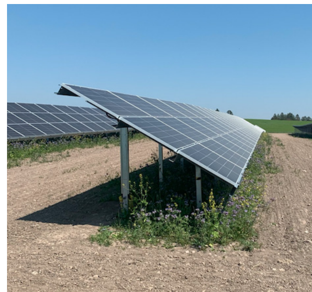
FIGUR 7 Exempel på solpaneler på markställningar. Den vänstra bilden visar pågående montering med markställningar utan solpaneler till vänster och markställningar med solpaneler till höger i bilden (foto: Magnus Fast, OX2).
