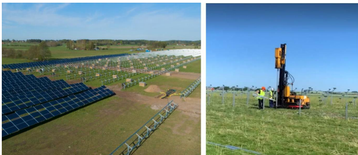
Figur 5. Vänster: exempel på montage av solpaneler på markställningar. Anläggningen är Svea Solars solenergianläggning i Sjöbo (Bildkälla: Ny Teknik). Höger: Pålning av stolpar med pålningsmaskin (foto: Magnus Fast, OX2).
