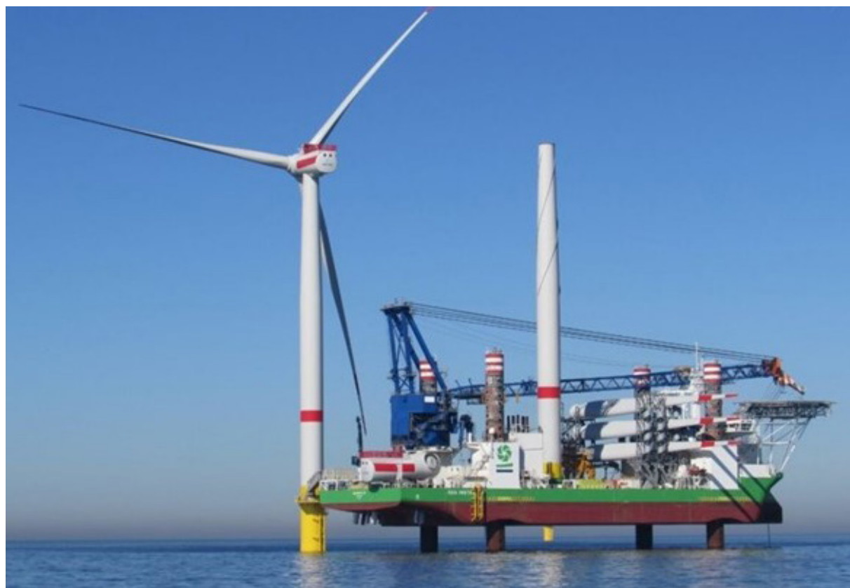
Figur 34. Montering av vindkraftverk med ett fartyg av typen jack-up. Källa: COWI.
